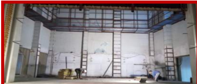
Vista de l'escenari amb els pilars ja reforçats amb una armadura de ferro. A la dreta es veu el nou accés a l'escenari que comunica amb l'edifici nou, els camerins, l'ascensor i el moll de càrrega.
