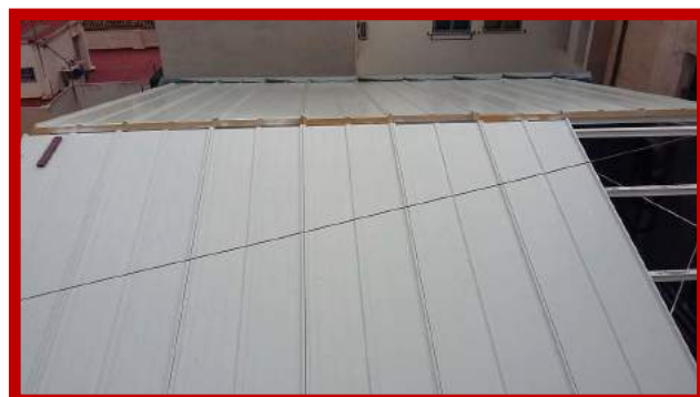
Nou tancament de la coberta amb panels tipus sandwich plens de poliuretà. En la part de baix s'ha col·locat la llana de roca i el pladur per a un millor aïllament tèrmic i acústic.
