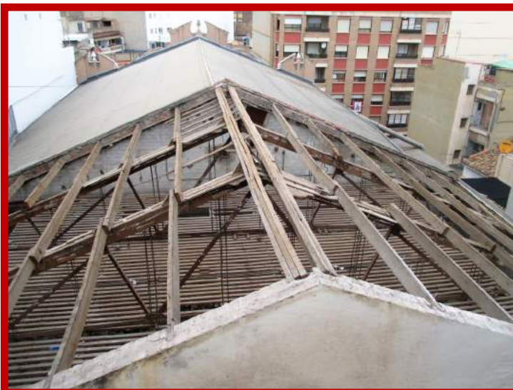
Estructura de la coberta de fusta amb els ganivets, cintres, corretges, bigues transversals i pintes.
