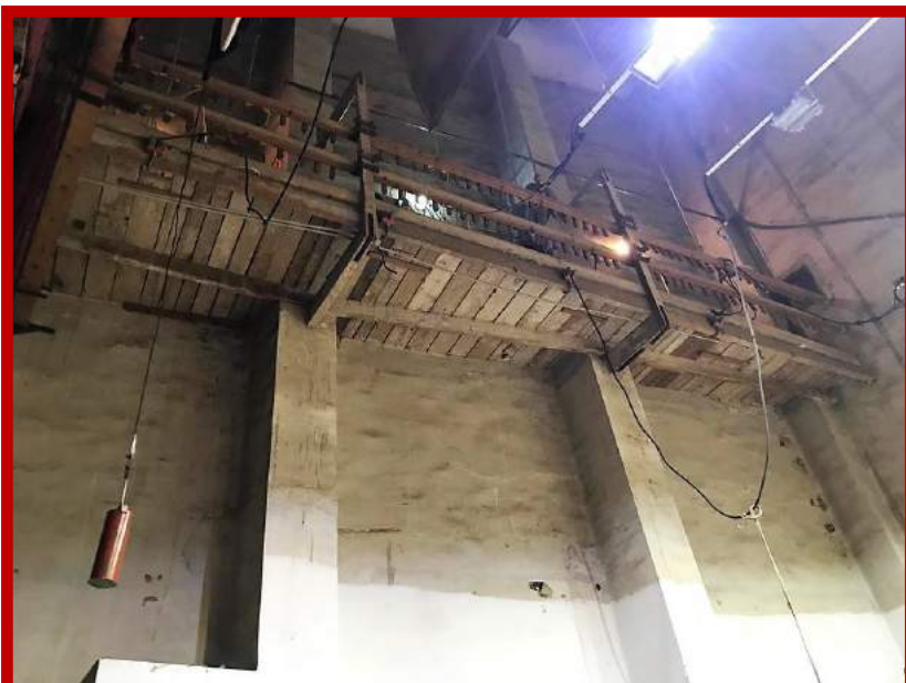
Vella passarel·la de fusta de la tramoia que s'ha desmuntat
