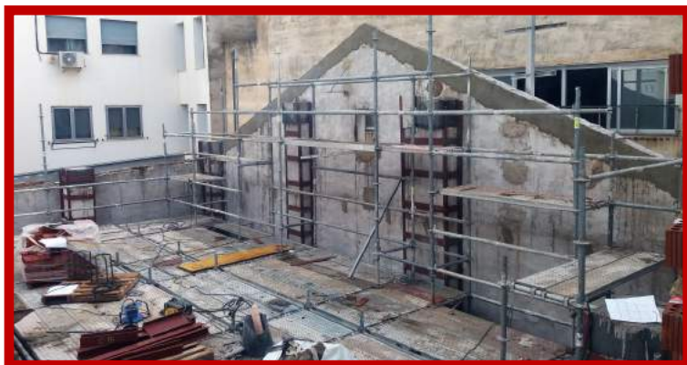
Vista de la plataforma de treball que cobria tot l'escenari i els pilars reforçats amb una armadura de ferro i rematats amb nanos de formigó armat.
