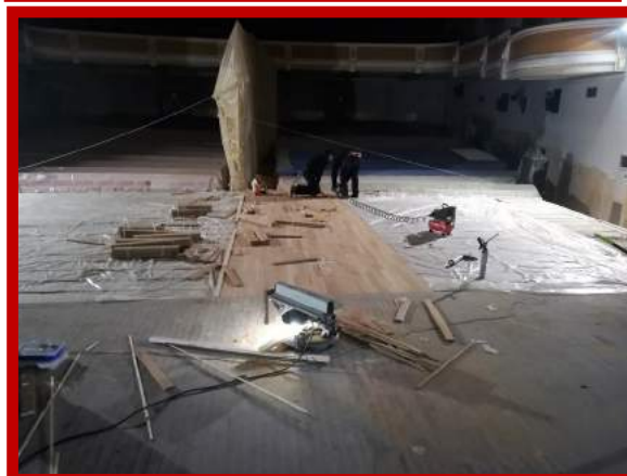
Col·locació del parquet.
