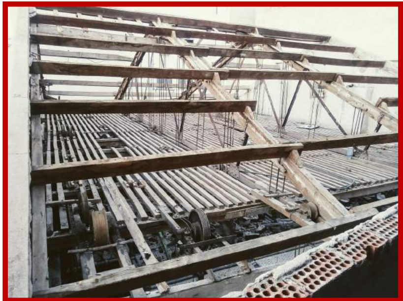
Coberta de fusta de l'escenari al descobert amb el peine de la tramoia.
