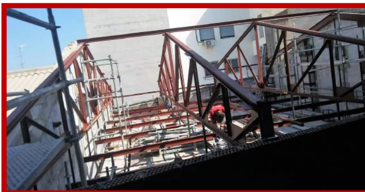
Estructura de la coberta amb les 4 cintres de ferro (abans en tenia 2 de fusta) que també suporten els travesers sobre els que es recolza el peine.
