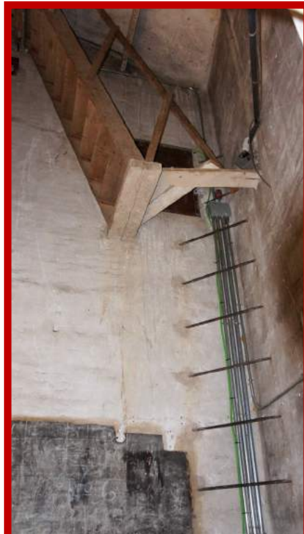
Antiga escala d'accés al peïne que s'ha substituït per una de ferro amb proteccions.
