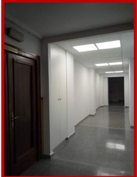
Corredor que comunica el nou edifici amb l'edifici antic, en concret en la sala d'assajos i sala de trofeus.
